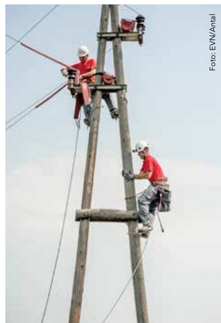
Montage von Vogelschutzhauben im Laaer Becken durch die „Netz Niederösterreich“.
