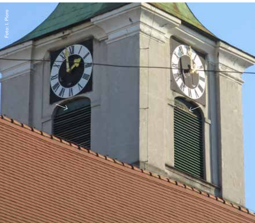
Links: Der Glockenturm der Paulanerkirche mit den Einfluglöchern für die Mauersegler im Schallfensterbogen. Oben: Nistkastenbox an der Rückseite der Einfluglöcher im Schallfensterbogen.
