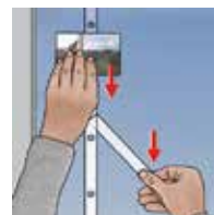
Punkte per Klebeband auf Glasflächen anbringen
