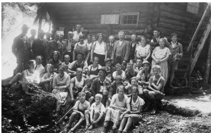
Eröffnung der Gasselhütte und der Gassel-Tropfsteinhöhle als Schauhöhle, Foto: Vereinsarchiv Ebensee 1933.
