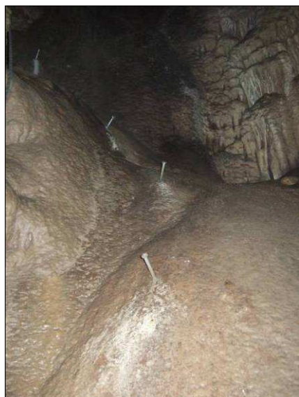
Abb. 3: Trittstifte auf einer Sinterplatte. Foto: B. Wielander
