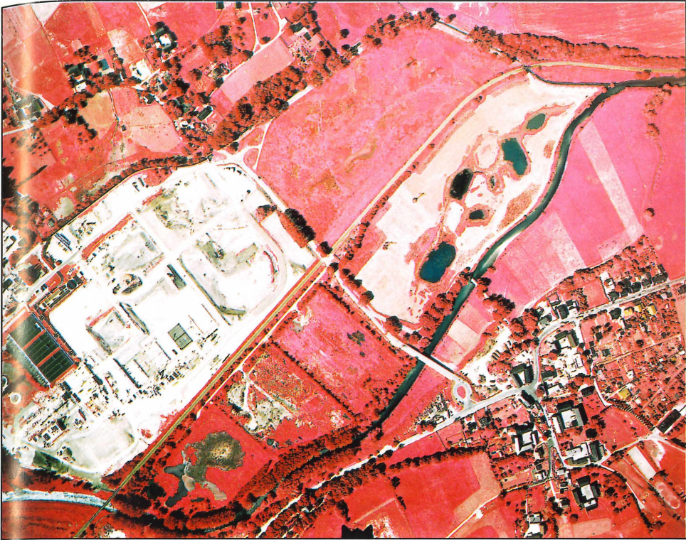
Abb. 2 Die im Bau befindliche neue Zentralkläranlage Chemnitz-Heinersdorf im Juli 1996. IR-Luftbildaufnahme der Stadt Chemnitz (Bildnummer 992).
