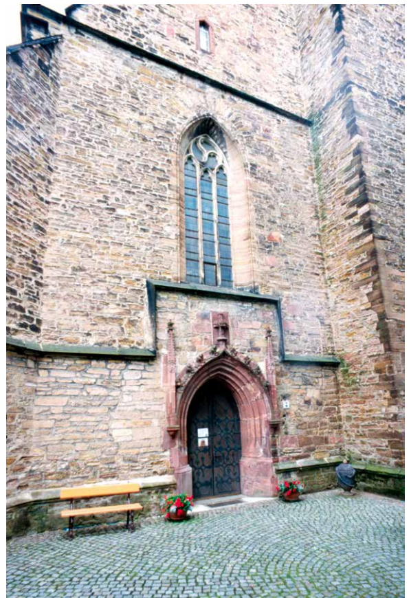
Abb. 4 Stiftskirche Chemnitz-Ebersdorf, Südportal.
