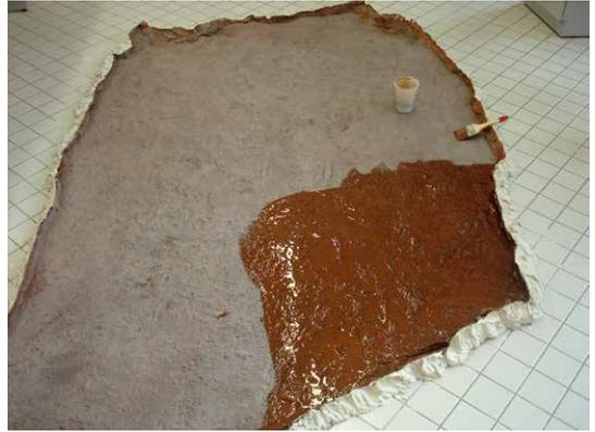
Abb. 11 Erste dünne Harzschicht.
