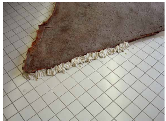
Abb. 9 Aufbau der Randarmierung mit Gips.
