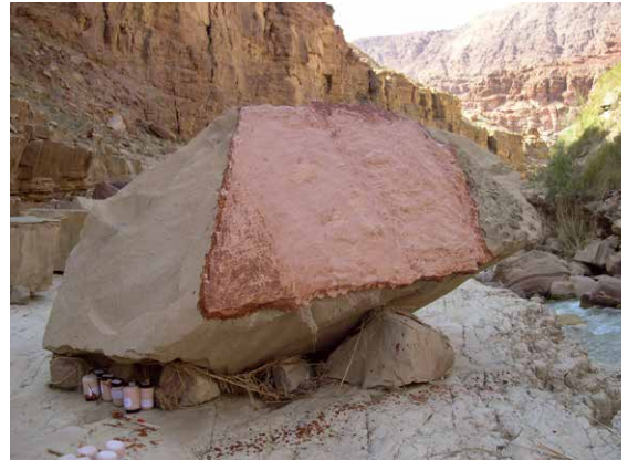
Abb. 3 Aufbringen der Speziallatex-Schichten und Einarbeitung des Stützgewebes.
