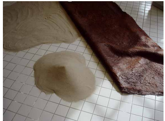
Abb. 8 Unterbau der Sandschicht.
