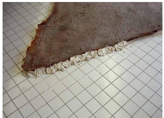
Abb. 9 Aufbau der Randarmierung mit Gips.
