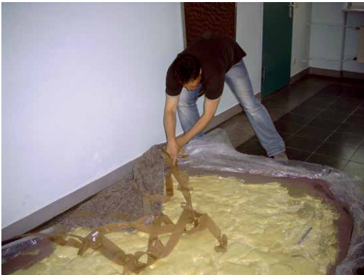
Abb. 12 Ausgeschäumte Rückseite - Felsabguss kurz vor der Wandmontage.
