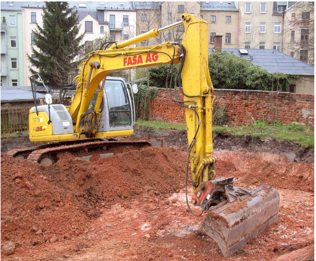
Abb. 11 Baggerarbeiten im Hangschutt durch die FASA AG am 07. April 2008.
