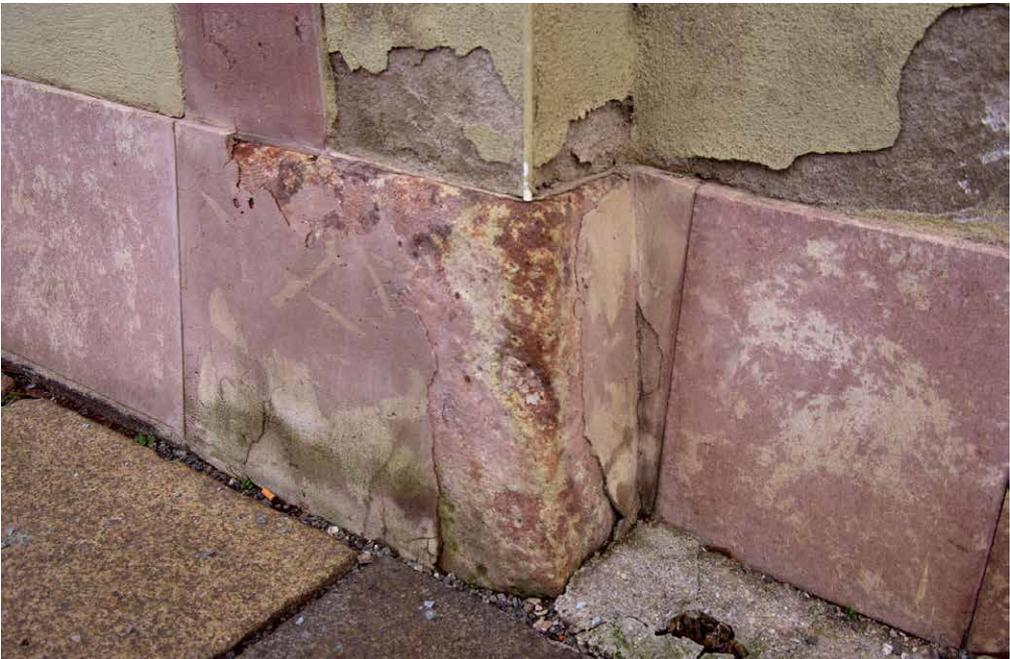
**Abb. 7** Mörtelergänzungen und Neuteile in einer verwitterten Sockelzone aus Hilbersdorfer Tuff.
