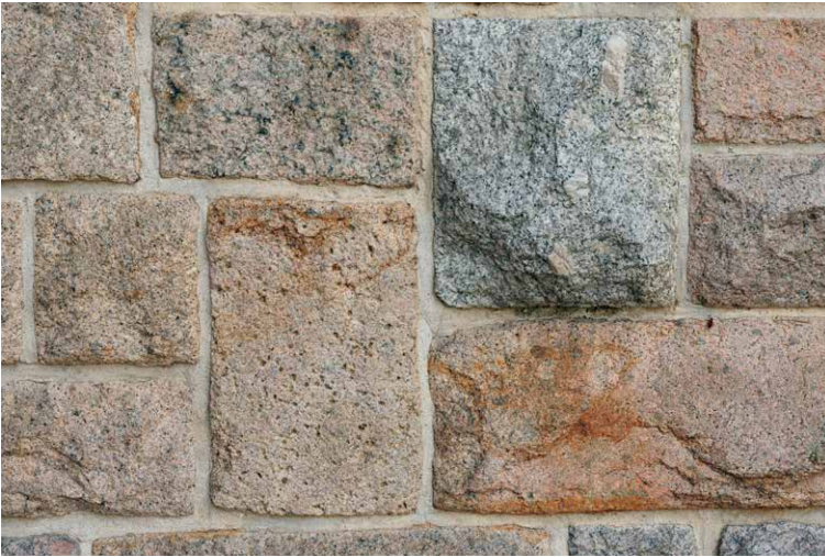
Abb. 14 Varietäten des Kirchner Granits im Quadermauerwerk am Eingangsbereich des Westsachsenstadions (Turmfassade 1939/40).
