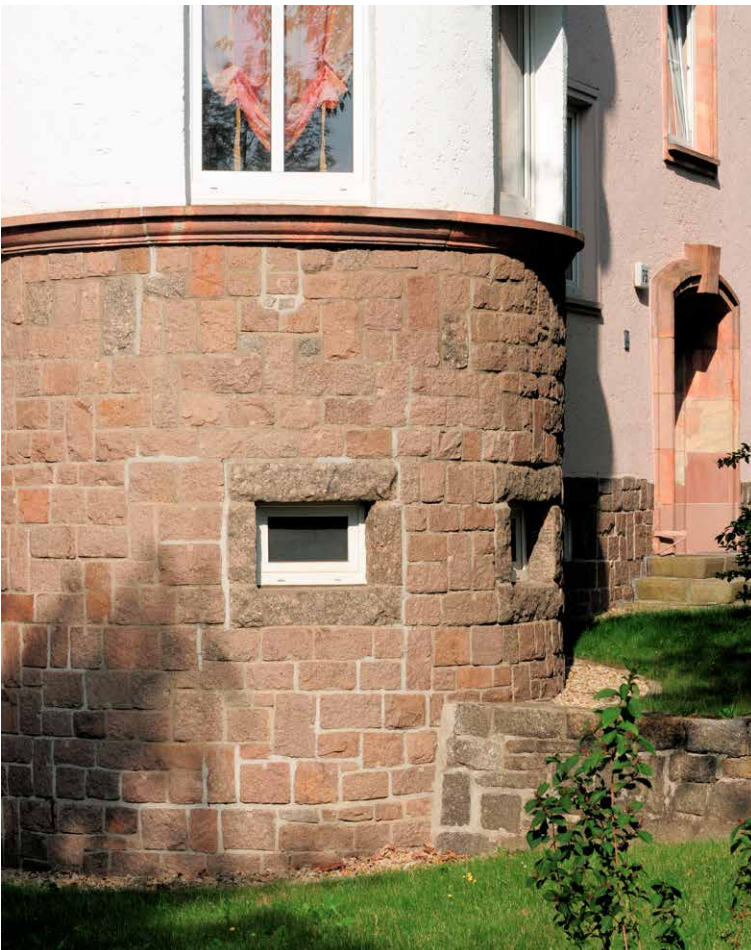
Abb. 15 Quadermauerwerk und Fenster- gewände aus Kirchner Granit an einem Wohngebäude aus den 1960er Jahren an der Werdauer Straße.
