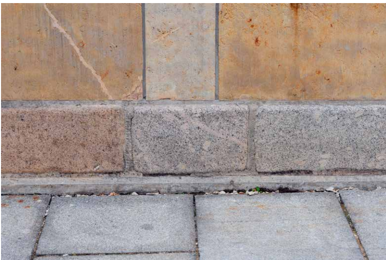
Abb. 12 Mauerwerk aus Kirchberger Granit im Sockelbereich des ehemaligen Kreiskrankenstifts (heute Robert-Schumann-Konservatorium).
