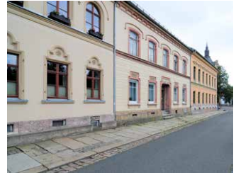
Abb. 16 Gebäudegruppe Dr.-Friedrichs-Ring 3-9 (1852) mit geflecktem Chemnitzer Zeisigwald-Tuff in Sockeln und Gesimsen sowie gelblich-grauem Buntsandstein.
