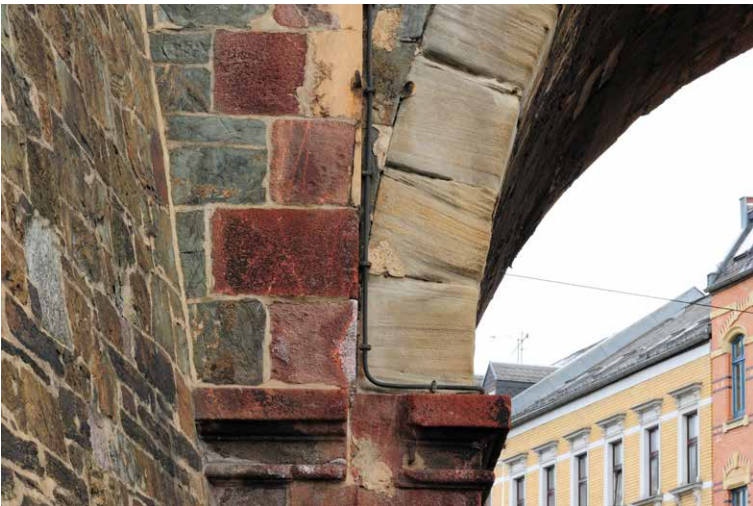
Abb. 17 Marienthaler Eisenbahnviadukt mit Werksteinen aus Rochlitzer Porphyrtuff (Eckquaderung) und Buntsandstein (Bogen) sowie Bruchsteinen aus meergrünem Diabas im Mauerwerk.
