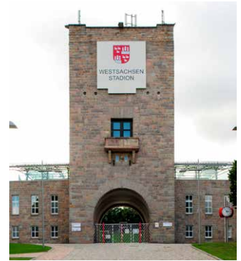
Abb. 14 Varietäten des Kirchner Granits im Quadermauerwerk am Eingangsbereich des Westsachsenstadions (Turmfassade 1939/40).
