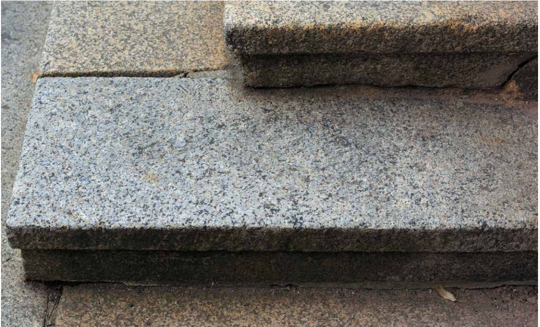
Abb. 26 Kösseine-Granit als Material für zwei seitliche Trittstufen der Eingangstreppe zur ehemaligen Bürgerschule (Peter-Breuer-Straße).
