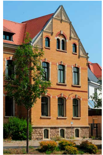
Abb. 12 Mauerwerk aus Kirchberger Granit im Sockelbereich des ehemaligen Kreiskrankenstifts (heute Robert-Schumann-Konservatorium).
