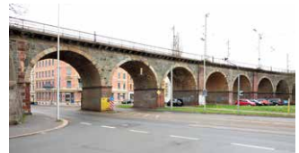
Abb. 17 Marienthaler Eisenbahnviadukt mit Werksteinen aus Rochlitzer Porphyrtuff (Eckquaderung) und Buntsandstein (Bogen) sowie Bruchsteinen aus meergrünem Diabas im Mauerwerk.
