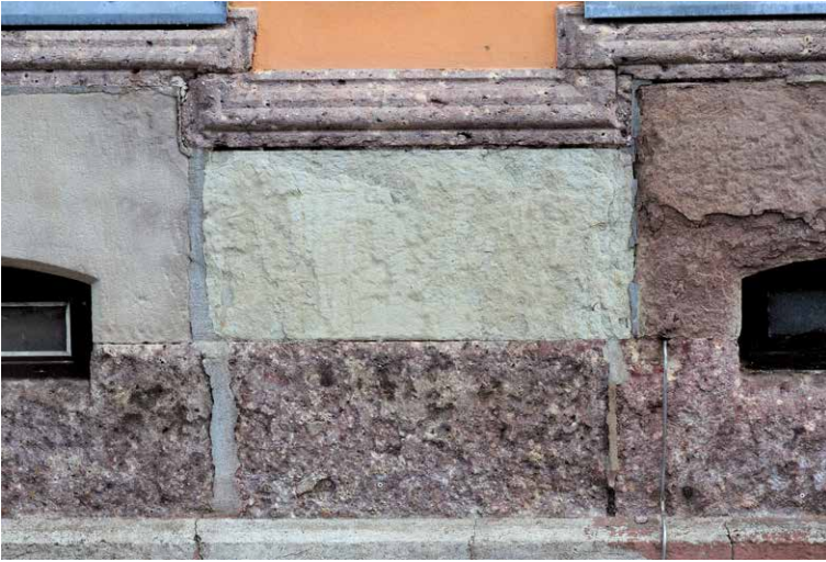
Abb. 16 Gebäudegruppe Dr.-Friedrichs-Ring 3-9 (1852) mit geflecktem Chemnitzer Zeisigwald-Tuff in Sockeln und Gesimsen sowie gelblich-grauem Buntsandstein.
