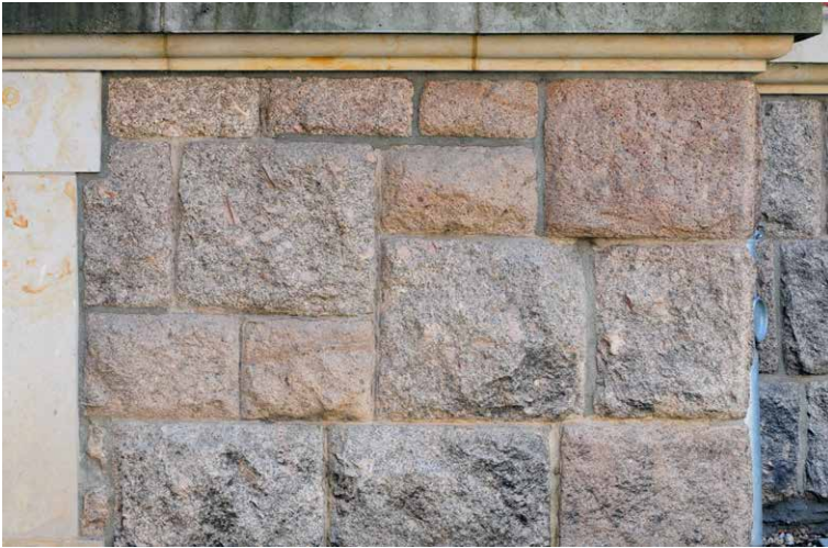
Abb. 12 Mauerwerk aus Kirchberger Granit im Sockelbereich des ehemaligen Kreiskrankenstifts (heute Robert-Schumann-Konservatorium).
