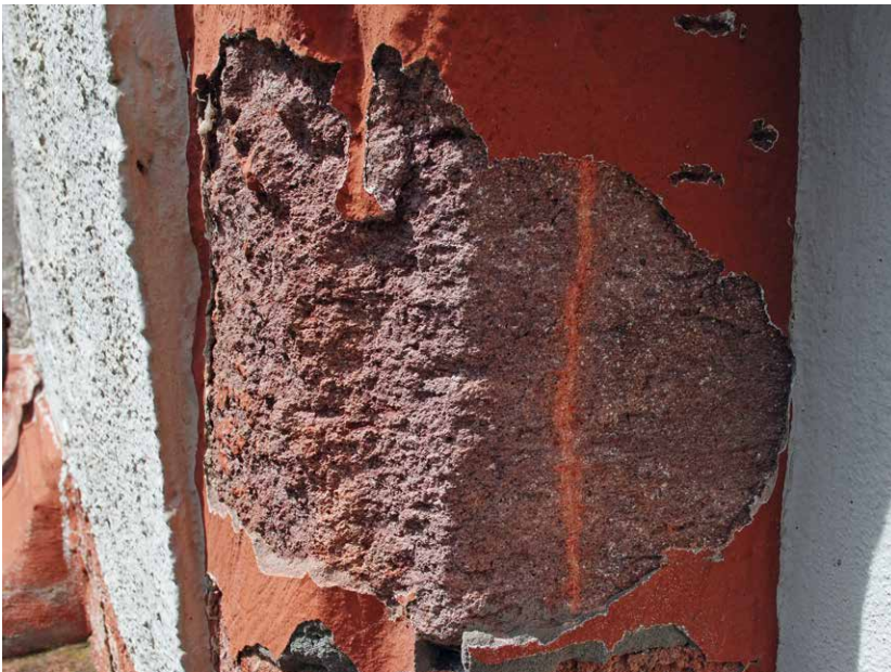
Abb. 8 Detail eines spätgotischen Portalgewändes von der Westseite der Marienkirche in Rötha aus gelblich grauem Tuffstein vom Rüdigsdorfer Typ mit Resten einer roten Farbfassung.
