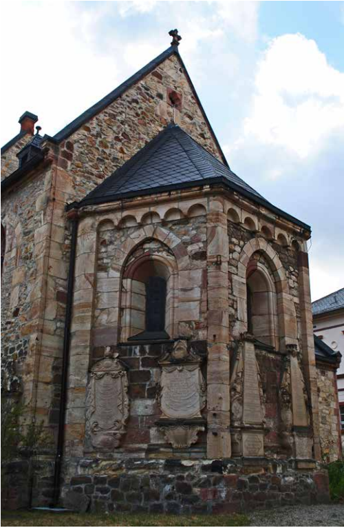
Abb. 4 Ansicht der Kirche St. Gangolf in Kohren-Sahlis (Anfang 13. Jh.) von Südosten. An der Apsis und im Chorbereich wurden behauene Werkstücke aus Rüdigsdorfer Tuff in gelblich-grauen und rötlich-violetten, teils gebänderten und gefleckten Varietäten verbaut. In den Fensterbögen der Apsis sind einzelne Steine später durch Rochlitzer Porphyrtuff ersetzt worden.
