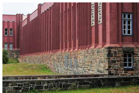
Abb. 25 | Reichenbach: Sockelgeschosszone der Textilfachschule mit unregelmäßigem Schichtmauerwerk aus Diabas.
