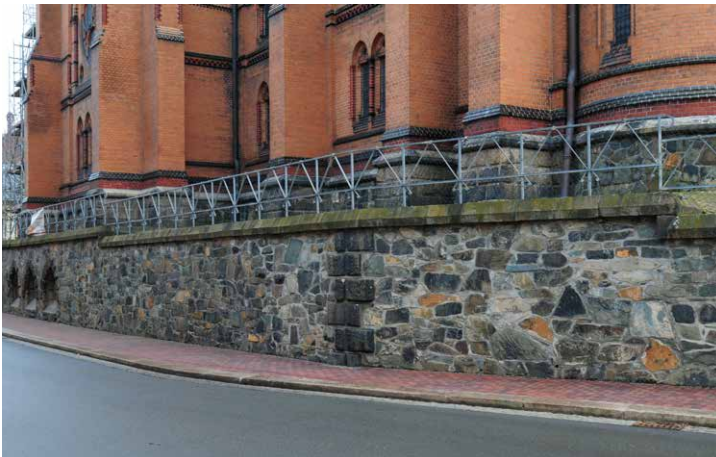
Mylau: Stadtkirche, Diabas als Bruchsteinmauerwerk an der Straßenseite und einfaches Polygonalmauerwerk im Bauwerksockel.
