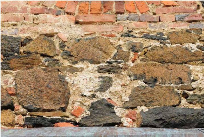
Abb. 14 | Mühltröff: Pikritstücke im Mauerwerk der Fassade des Westflügels von Schloss Mühltröff.
