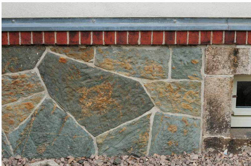
Abb. 10 | Ebersbrunn: Pfarramtsgebäude (1892) mit polygonalem Sockelmauerwerk aus Diabas.
