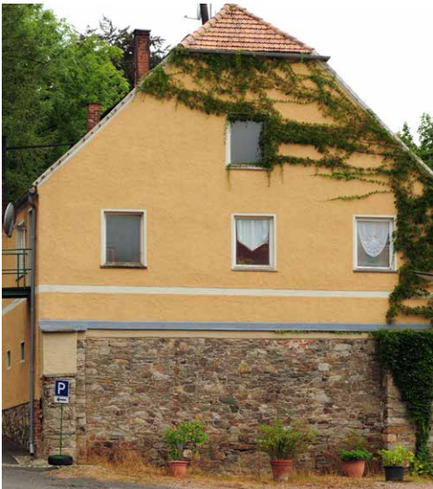
Neumark: Rittergut aus Bruchsteinmauerwerk mit Diabas (grün) und anderen regionalen Gesteinen.
