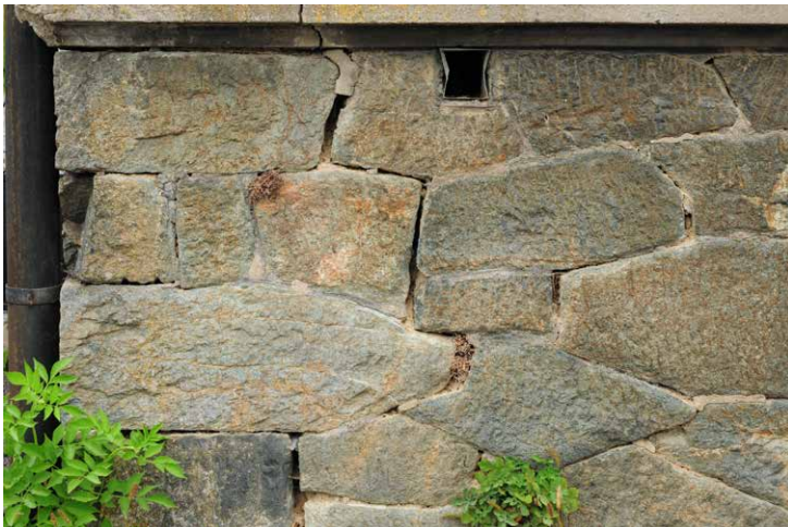
Abb. 28 | Thierbach: Sockelzone an einem Wohngebäude aus Diabasstücken mit manueller Oberflächenbearbeitung.
