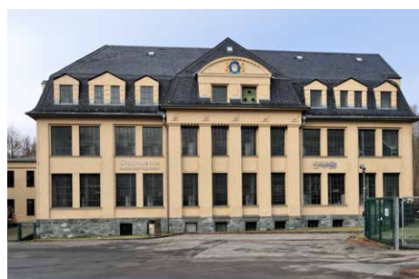
Abb. 26 | Reichenbach: Sockelzone des Umspannwerkes mit aufwändig bearbeiteten Diabasquadern.
