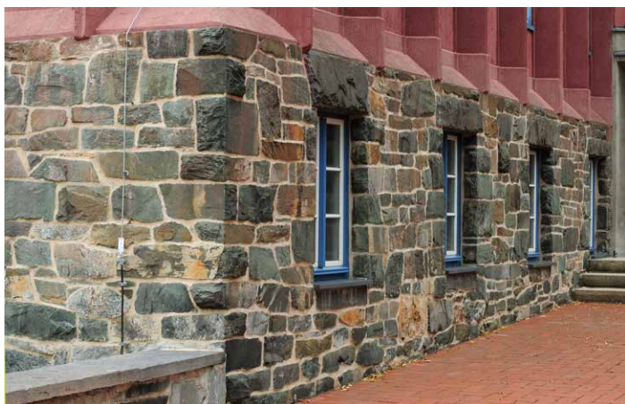
Abb. 25 | Reichenbach: Sockelgeschosszone der Textilfachschule mit unregelmäßigem Schichtmauerwerk aus Diabas.
