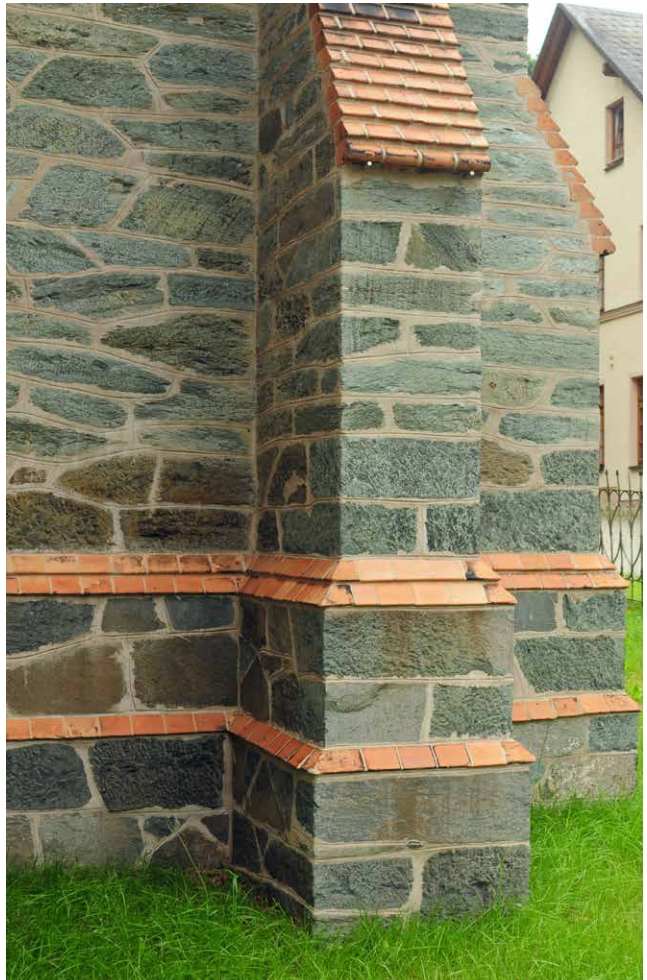
Dröda: Kirchenbau mit unregelmäßigem Schichtmauerwerk aus Diabas in Kombination mit Klinkerelementen. | Abb. 9
