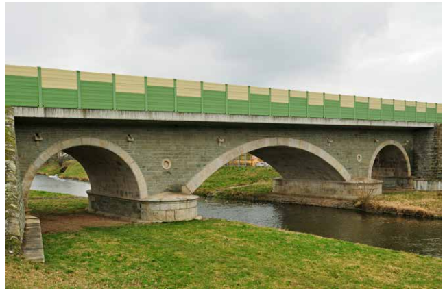
Abb. 18 | Oelsnitz: Ehemalige Eisenbahnbrücke der Strecke Herlasgrün-Falkenstein-Oelsnitz, regelmäßiges Diabasquadermauerwerk in den Pfeilerflächen.
