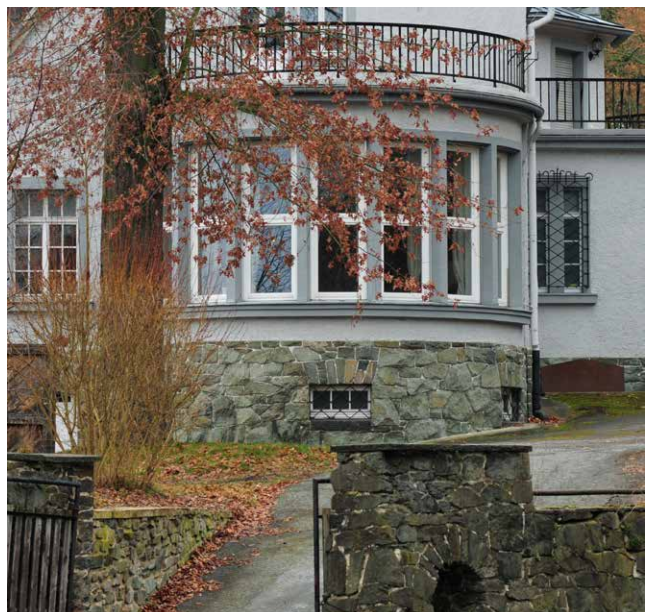
Oelsnitz: Haus Turmfried an der Forststraße, Mauerwerk im Sockel und Gestaltung der Grundstückseinfahrt mit Diabas. | Abb. 19
