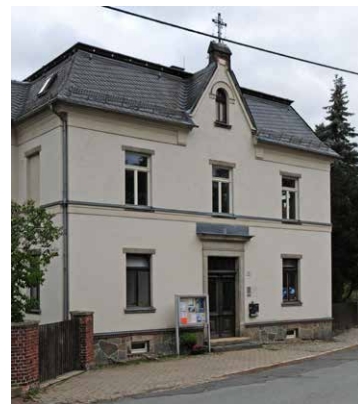
Abb. 10 | Ebersbrunn: Pfarramtsgebäude (1892) mit polygonalem Sockelmauerwerk aus Diabas.
