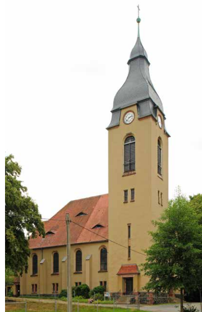
Lichtentanne: Christuskirche mit rustikalem Natursteinsockel aus Diabas und Rochlitzer Porphyrtuff als Eckquader. | Abb. 13
