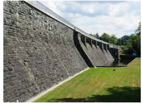
Abb. 21 | Pirk: Die Mauer der Talsperre wurde an ihrer Luftseite mit Diabasquadern verkleidet.
