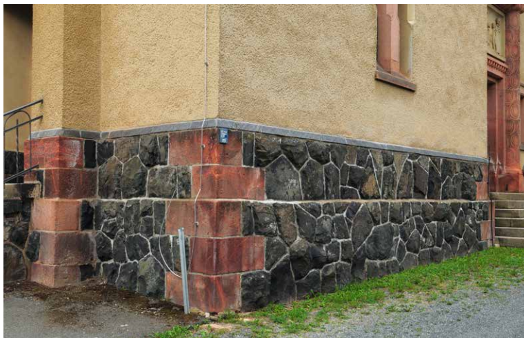
Lichtentanne: Christuskirche mit rustikalem Natursteinsockel aus Diabas und Rochlitzer Porphyrtuff als Eckquader. | Abb. 13
