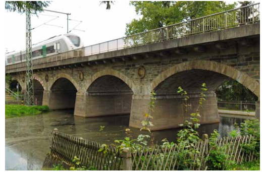
Abb. 11 | Grobau: Eisenbahnviadukt mit unregelmäßigem Flächenmauerwerk aus Diabas.
