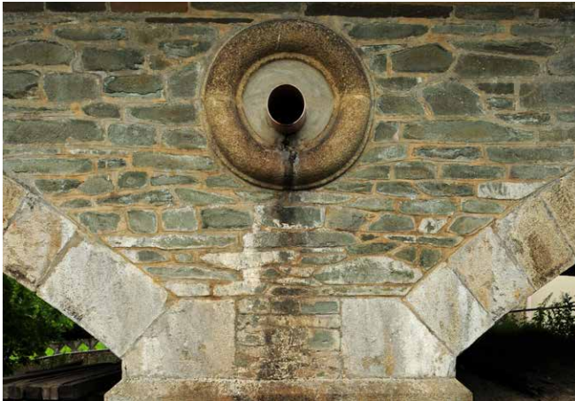
Abb. 11 | Grobau: Eisenbahnviadukt mit unregelmäßigem Flächenmauerwerk aus Diabas.
