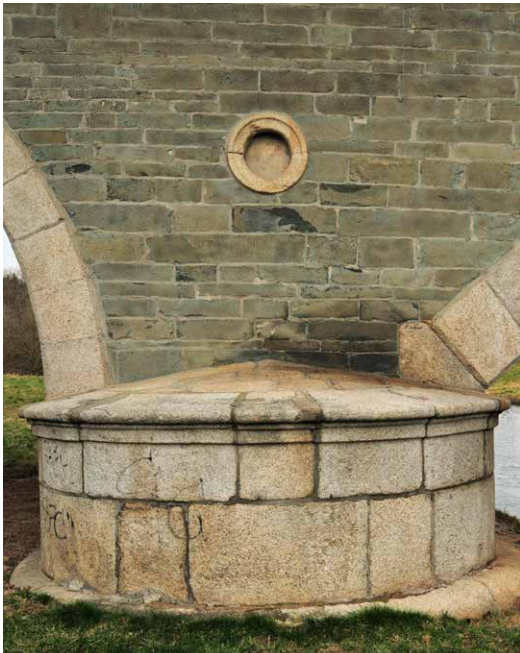
Abb. 18 | Oelsnitz: Ehemalige Eisenbahnbrücke der Strecke Herlasgrün-Falkenstein-Oelsnitz, regelmäßiges Diabasquadermauerwerk in den Pfeilerflächen.
