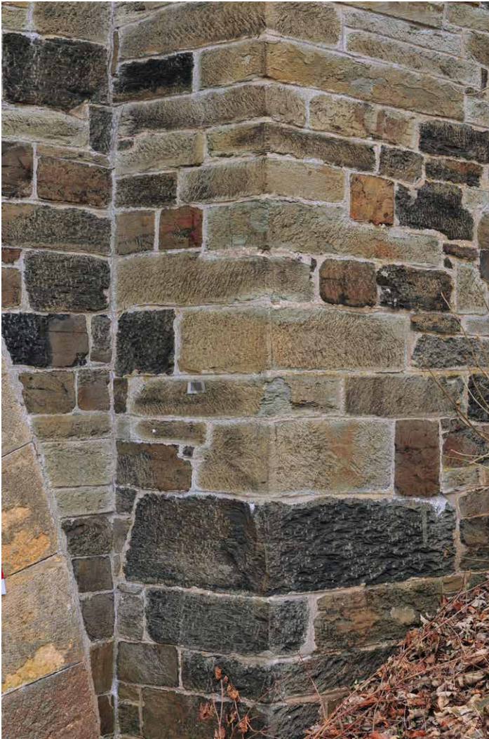
Abb. 23 | Plauen: Syratalbrücke der Eisenbahnstrecke Plauen–Schönberg–Cheb/Eger, Schichtmauerwerk mit Diabas- tuff.
