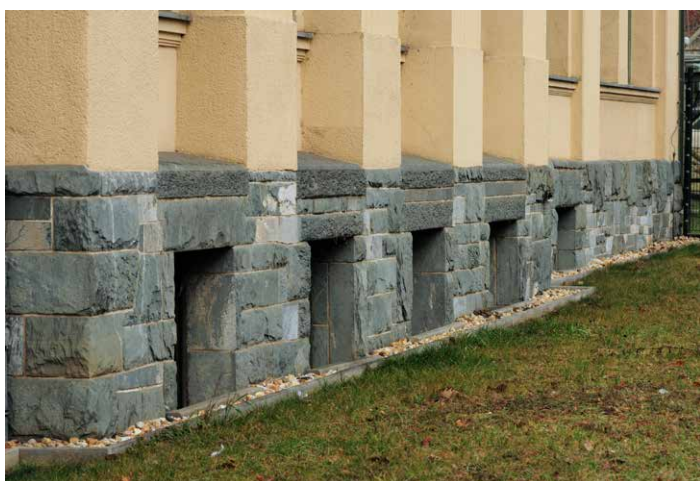
Abb. 26 | Reichenbach: Sockelzone des Umspannwerkes mit aufwändig bearbeiteten Diabasquadern.
