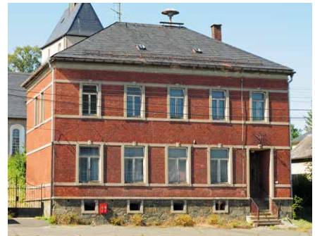
Abb. 28 | Thierbach: Sockelzone an einem Wohngebäude aus Diabasstücken mit manueller Oberflächenbearbeitung.
