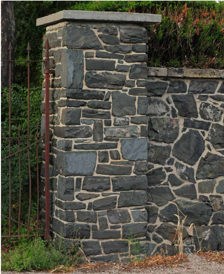
Abb. 27 | Stenn: Bruchsteinmauerwerk an der Friedhofsmauer und Schichtmauerwerk am Pfeiler.
