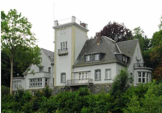
Oelsnitz: Haus Turmfried an der Forststraße, Mauerwerk im Sockel und Gestaltung der Grundstückseinfahrt mit Diabas. | Abb. 19
