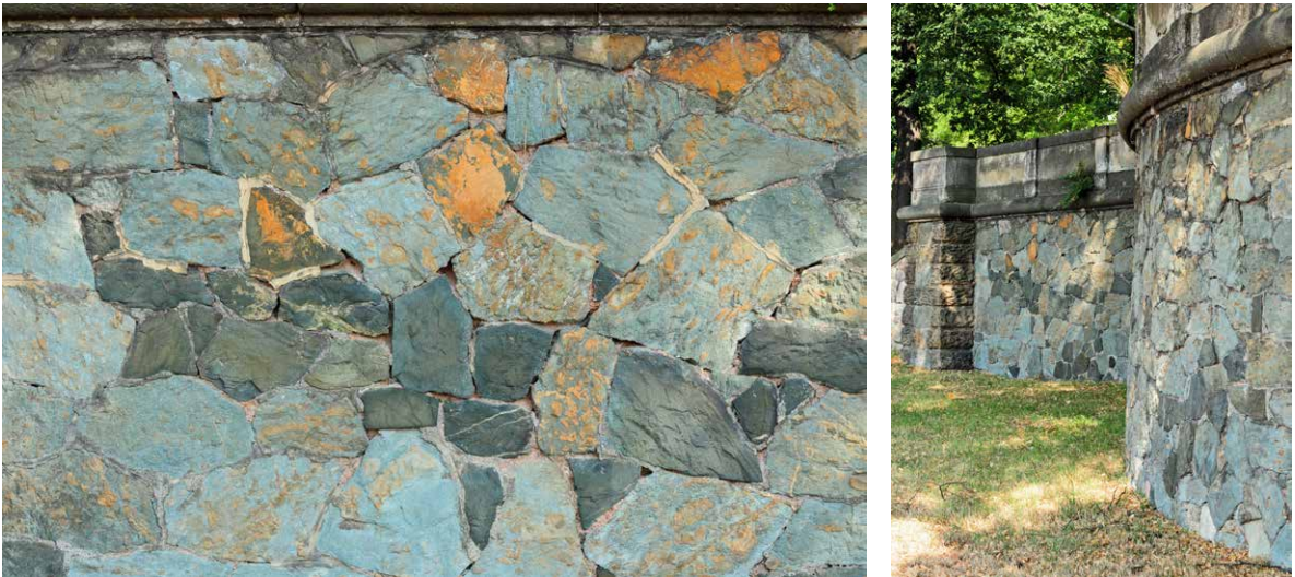
Abb. 32 | Zwickau-Marienthal: Böschungsmauer an der ehemaligen Infanteriekaserne (Werdauer Straße), Gartendenkmal.
