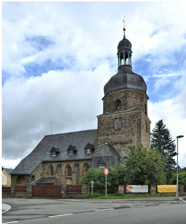
Die gute Teilbarkeit des Gesteins entlang der Schieferungsebenen und Klüfte in Platten und Blöcke begünstigte die Herstellung von Mauersteinen mit ebenen Verlegeflächen, die dadurch einfach zu versetzen waren. Dünne Spaltbarkeit bei hoher Festigkeit und Dichtigkeit sowie die rutschhemmende Wirkung der rauen Spaltoberfläche waren zugleich auch gute Voraussetzungen für eine Verwendung von Fruchtschieferplatten als Fußbodenbelag, eine weitere verbreitete Nutzungsform.
