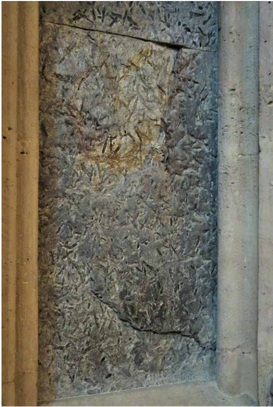
Abb. 21 | Brandgeschädigte originale Garbenschieferplatte vom Dorsale im Westchor des Naumburger Doms mit Abplatzungen.
