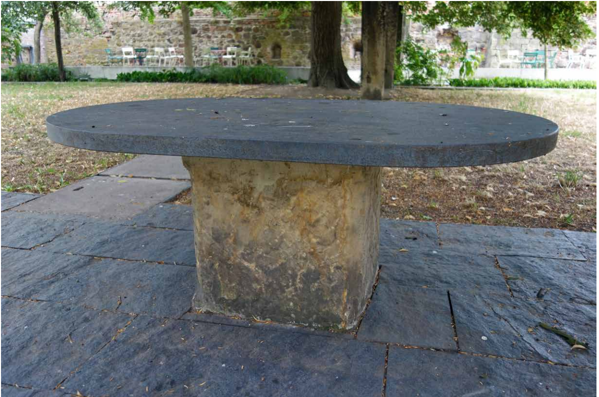
Abb. 9 | Im Garten des Melanchthonhauses wurde die historische Tischplatte aus Wechselburger Garbenschiefer durch eine neue Platte aus Theumaer Fruchtschiefer ersetzt.
