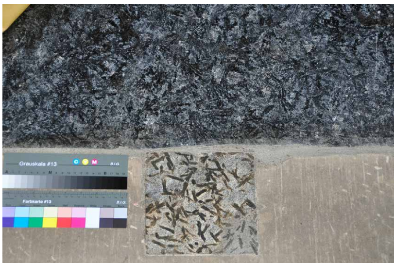
Abb. 22 Platten aus Wechselburger Garbenschiefer, eingelassen in die Sandstein-Mensa des Altars der Ulrichkirche in Halle/S., heute in der Wallonerkirche in Magdeburg (Foto: Karsten Böhm).
