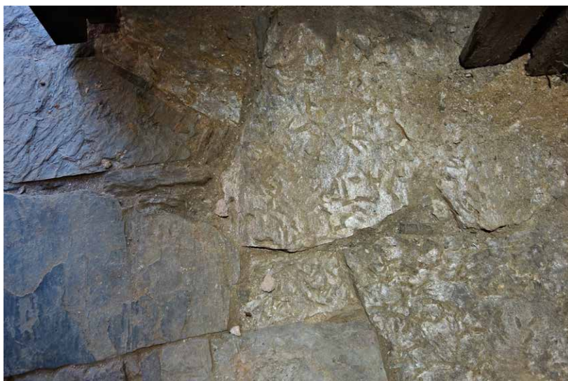
Abb. 23 Unformatierte Garbenschieferplatten neben Dachschieferplatten als Fußbodenbelag im Eingangsbereich des Nordportals der Kirche St. Otto in Wechselburg.
