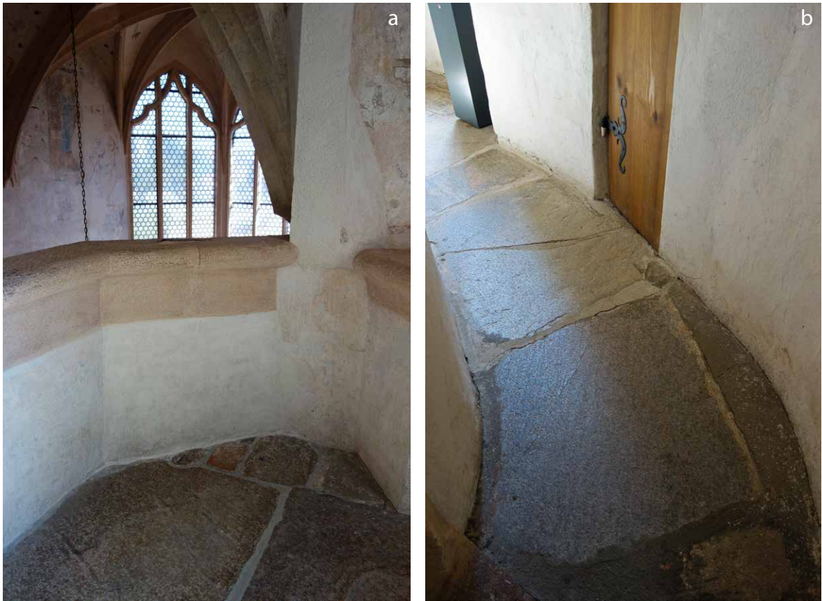
Abb. 12 | Bodenplatten aus Fruchtschiefer im Fußbodenbelag der Fürstenloge in der gotischen Schlosskapelle von Schloss Rochlitz (a) sowie im Boden von deren Zugang (b)
