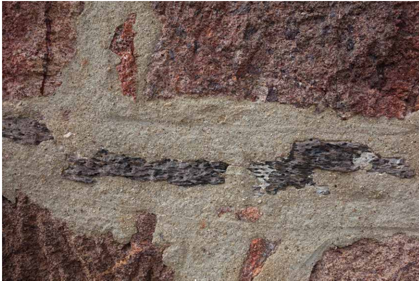
Abb. 13 | Mauerwerk aus Porphyrtuff mit Abstandhalter aus Fruchtschiefer in der Mörtelfuge an einem Haus in Rochlitz. Die Aluminiumsilikate im Fruchtschiefer sind ausgewittert und bilden Hohlformen.
