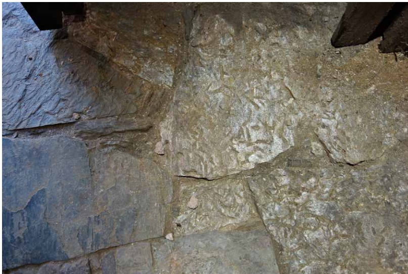
Abb. 23 Unförmige Garbenschieferplatte neben Dachschieferplatten als Fußbodenbelag im Eingangsbereich des Nordportals der Kirche St. Otto in Wechselburg.
