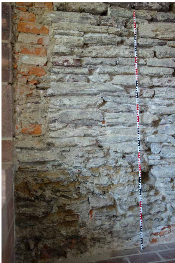
Abb. 10 | Schräg verlegte Fruchtschieferplatten im Kern des romanischen Mauerwerks von Wohnturm I im Schloss Rochlitz, datiert um 1115. Darüber horizontal versetzte Fruchtschieferplatten des gotischen Mauerwerks (um 1370).
