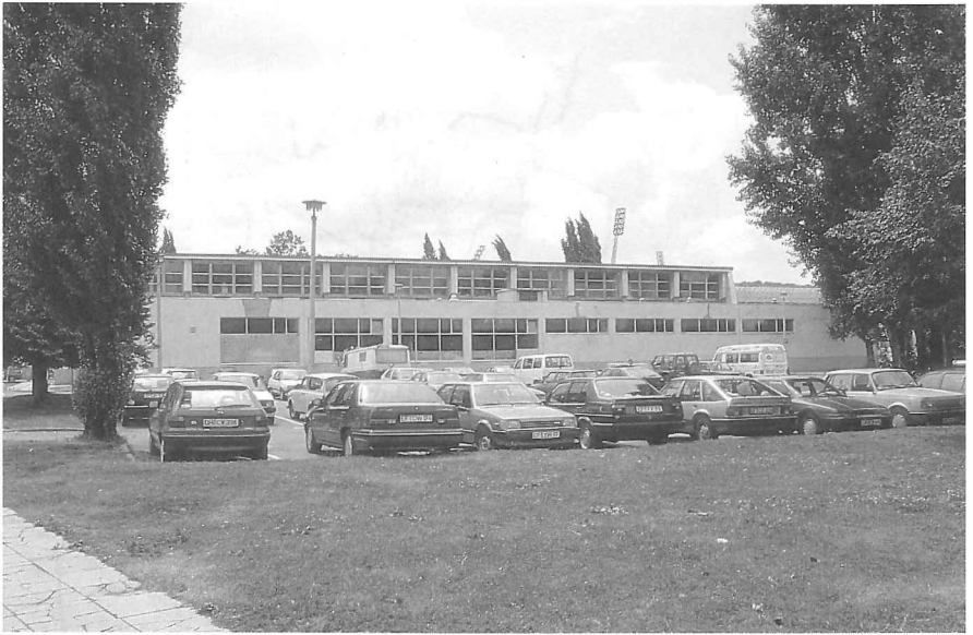
Abb. 3: Die Nordfassade der Schwimmhalle Süd beherbergt die größte Brutkolonie der Mehlschwalbe in Erfurt
