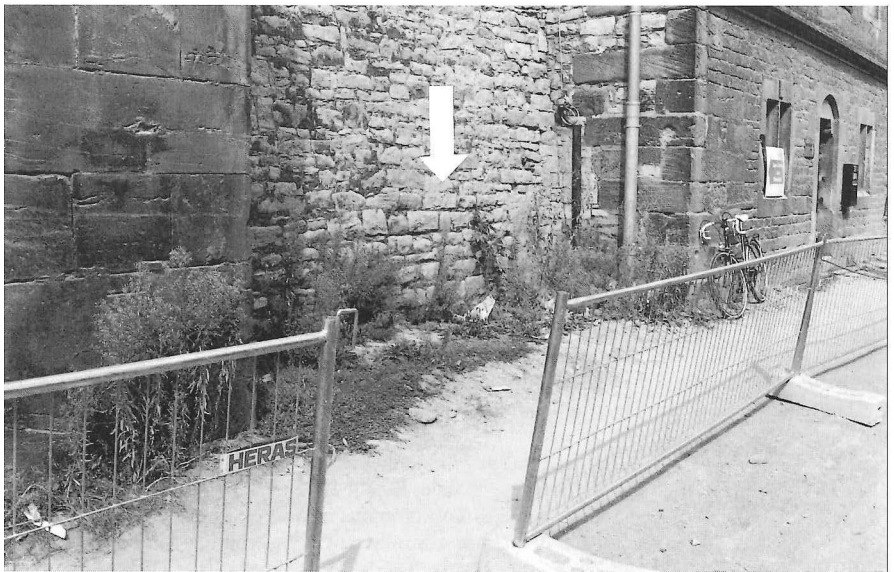
Abb. 2: Mauereinbuchtung an der Dom-Südseite in Erfurt mit Chenopodium vulvaria , Foto: J. Pusch, September 1996
