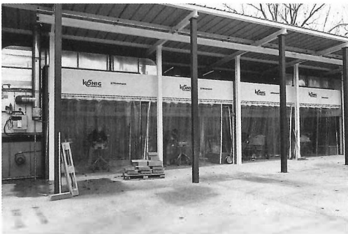
Abb 5: Belüftete Steinmetzkabinen im Travertinwerk Bad Langensalza
