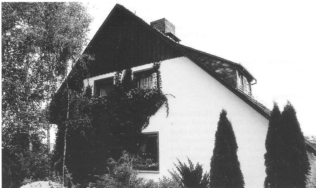
Abb.1: Hinter der Holzverkleidung und unter dem Schieferdach des Wohnhauses der Fam.Hirt (Töttelstedt) finden sich seit Jahrzehnten die Fledermäuse zur Wochenstubenzeit ein.
