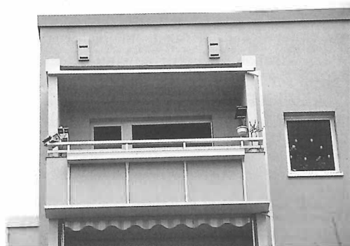
Abb. 4: In die Fassadendämmung integrierte Fledermausflachkästen an einem Plattenbau im Wohngebiet Wiesenhügel
