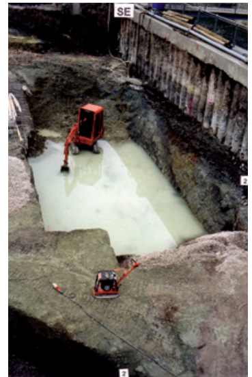
Abb. 4–6: Fotos zur Aufschluß-Situation in der Baugrube nahe der Kreuzung Peterstraße/ Maximilian-Welsch-Straße (Aufn. Tor. Krause, April 2004). Ausstrich von Unterem Keuper, Grenzdolomit (- 1 -) und Unterem Gipskeuper mit (?) Bochinger-Bank (- 2 -).
