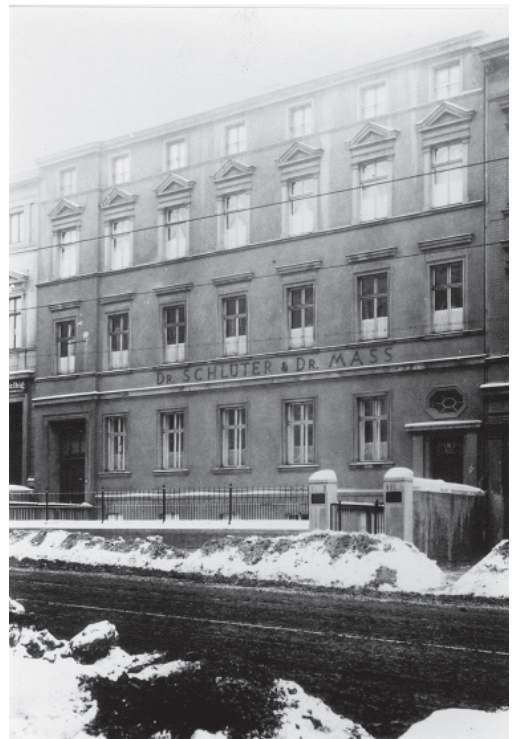
Abb. 4: Die ständige wachsende Nachfrage erforderte bald ein eigenes Geschäftsgebäude. In der Ludwig-Wucherer-Straße 9, Halle/S. war die Fa. SCHLÜTER von 1875 bis 1961 ansässig. Hier die Vorderfront des Geschäftsgebäudes im Jahre 1938. Foto: Schlüter-Archiv am Naturkundemuseum Erfurt.
