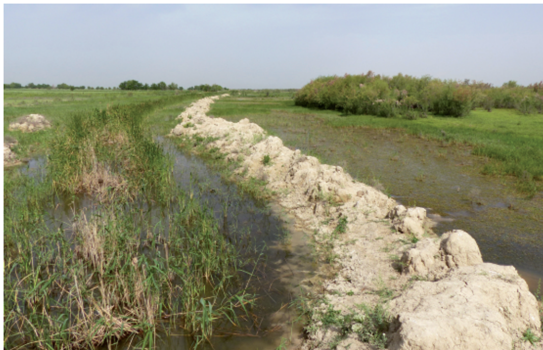
Abb. 2: Angestaute Wasserfläche mit aufgeschüttetem Damm (alle Fotos H. Grimm)
