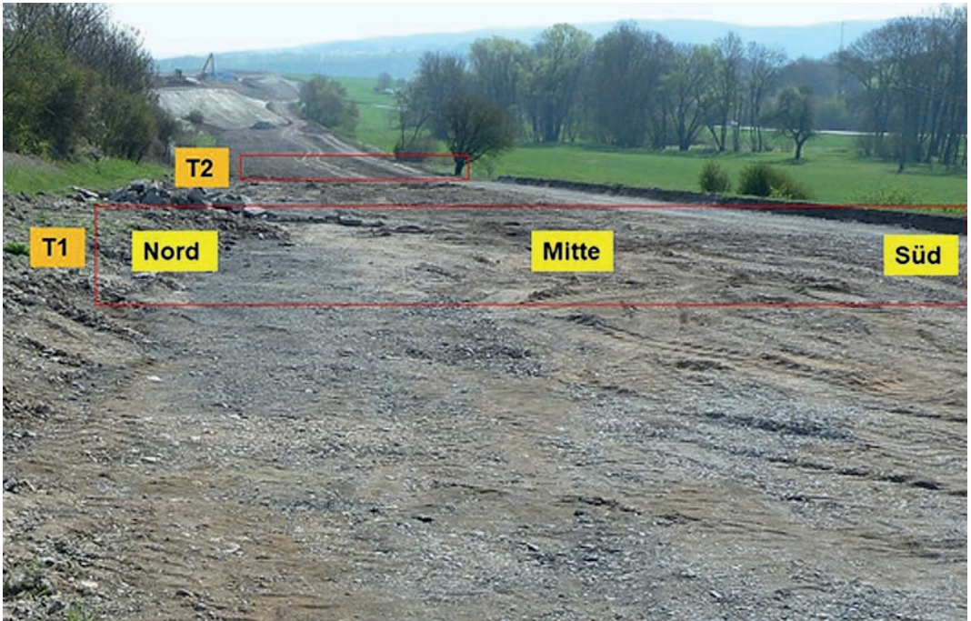
Abb. 1: Die A4-Trasse im östlichen Leutatal unmittelbar nach Rückbau mit den beiden Beobachtungstranssekten (T1 und T2), 24.04.2015. Foto: G. Köhler.
