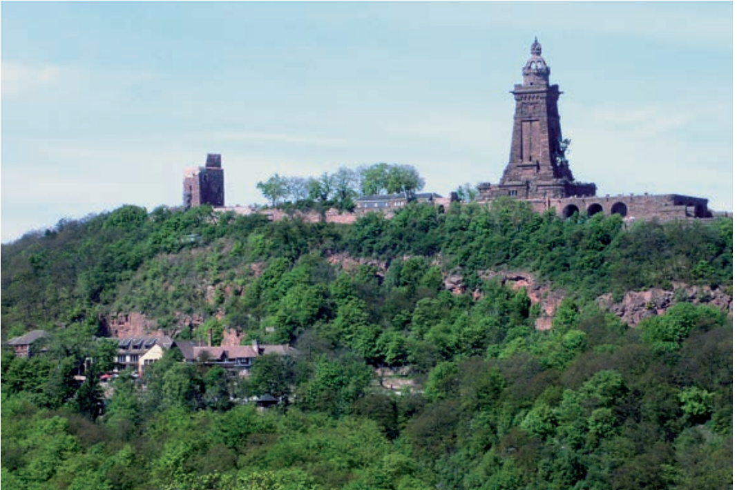
Abb. 2: Blick auf das Kyffhäuserdenkmal von S, Foto: H. Grimm
