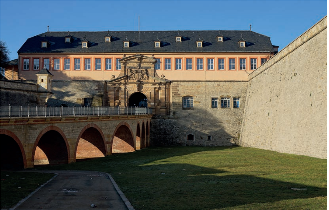
Abb. 2: Kommandantenhaus der Zitadelle Petersberg mit Petersbrücke. Rechts im Bild die Südmauer der Bastion Leonhard mit spärlichem Bewuchs von Mauer-Zimbelkraut, davor intensiv gemähte Grünanlage (01.01.2020). Alle Fotos: H. Baumbach.
