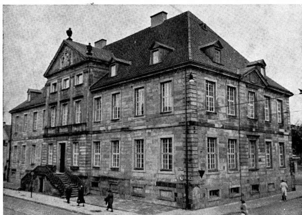
Bischöfl. Kanzlei, Hasestr. (1783/85), Osningsandstein. Stbr. Hochholz, Str. Oesede—Iburg.
