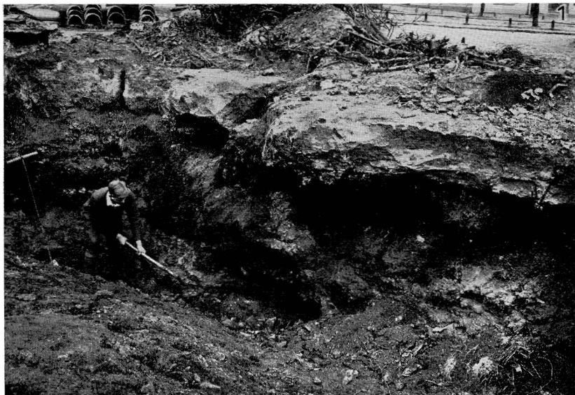
Abb. 25. Südstoß des Schlingmannschen Bruches (im Dorfe), 1930. Oben Sinterkalk, darunter Piepstein mit Emys orbicularis L., darunter Grott. In Höhe der Spitzhacke Sinterkalk, darunter wieder Piepstein.
