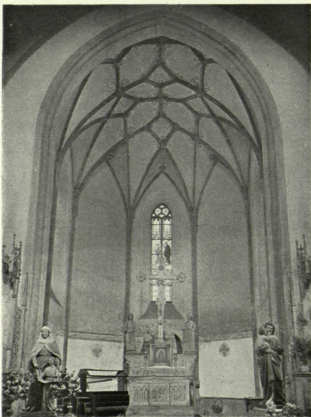
Abb. 2 Chorgewölbe der St. Johanneskirche.
