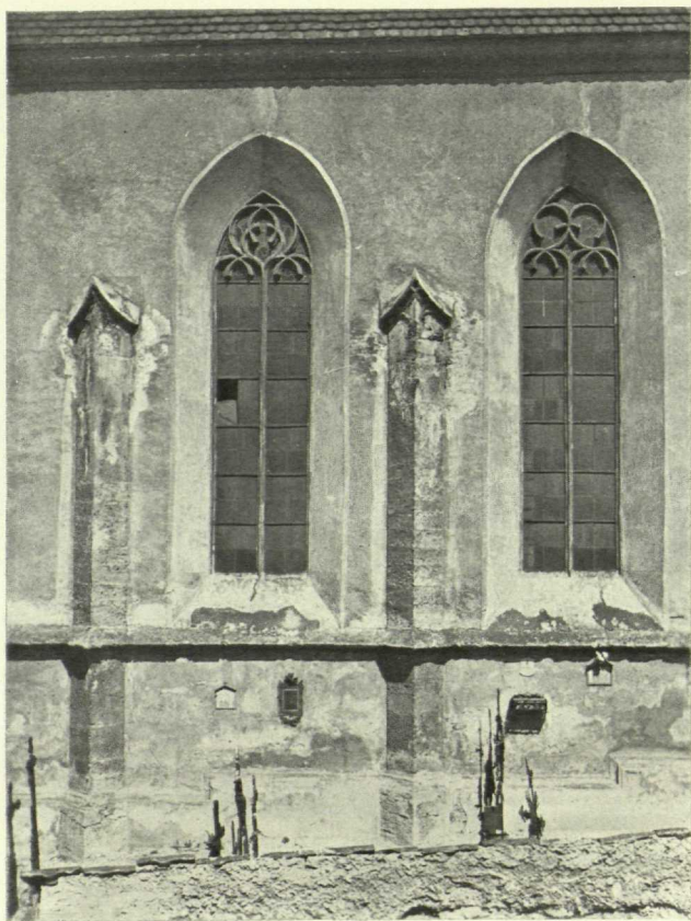
Abb. 8 St. Johanneskirche in Matrei, Südwand.
