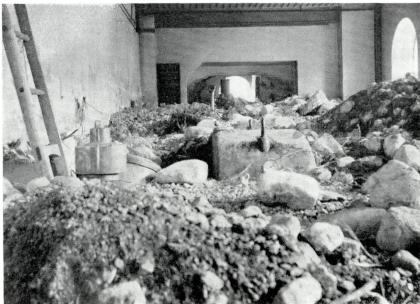
Bild 4. Vermurte Genera- toren im Mühlaue Elektrizitätswerk (Aufn. H. Heuberger, 4. II. 51)
