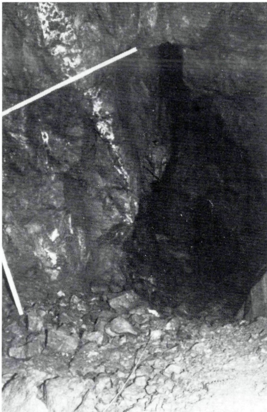
Abb. 1 Stollenquerschnitt im Westflügel des Maria-Lichtmeßstollen. Eisenkarbonatvererzung zirka 2 m mächtig. In postkristalline Kluft drang milchiger Quarzgang und verkitete abgescherte Eisenkarbonatteilchen (Gangbrekzie).
