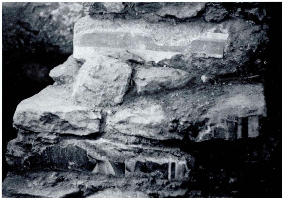
Abb. 47 Fundament des Stützpfilers (Abb. 36 D) mit vermauerten Resten spätgotischer Wandmalerei.
