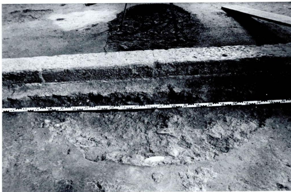
Abb. 43 Störung im frühgotischen Boden vor Chorstufe.
