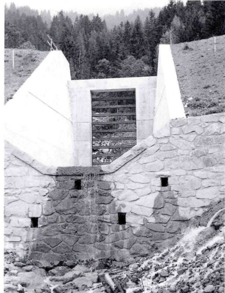
Abb. 8. Oberste Geschiebedosiensperre mit Gitterrost
