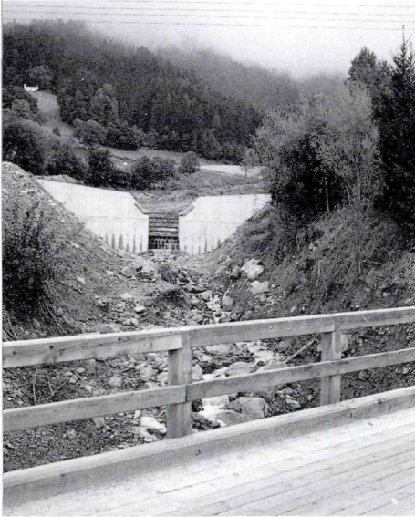
Abb. 10. WALLNER BRÜCKE, Geländekorrekturen, die im Zuge des Baues der obersten Sperre notwendig waren (1997-98) und zweite neue Sperre unmittelbar ober der Brücke.
