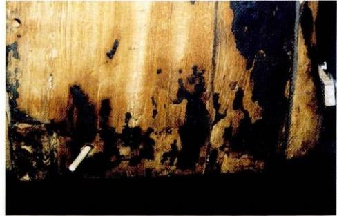
Abb. 26: Zusammensetzung mit Dübeln und eingefärbte Dübelköpfe
