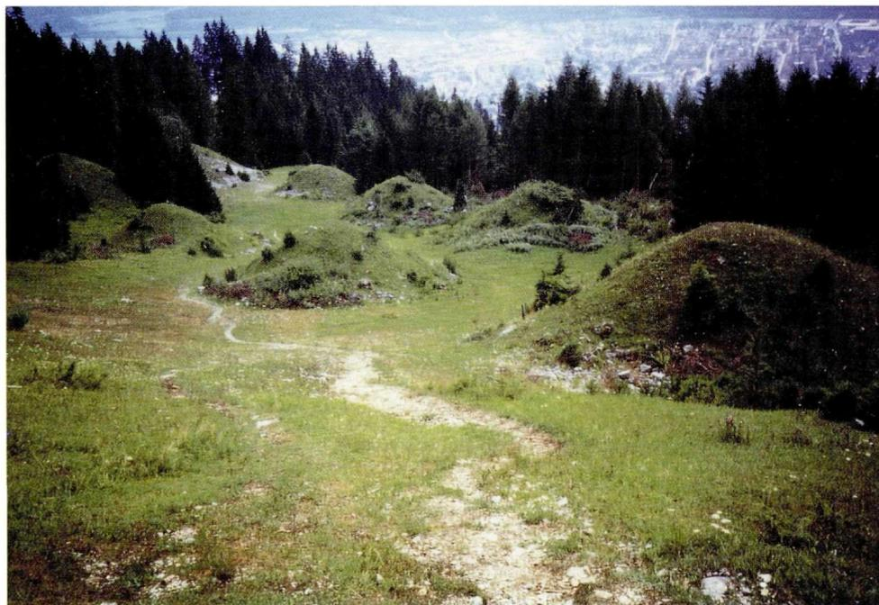
**Foto 3:** Verbauung einer Lawinenbahn auf der Nordkette oberhalb von Innsbruck. Zwischen den Kegeln kommt die Lawine schadlos zum Stillstand, aber ihre Bahn bleibt erhalten. Die ehemalige Sturzbahn wurde zur Akkumulationszone.
