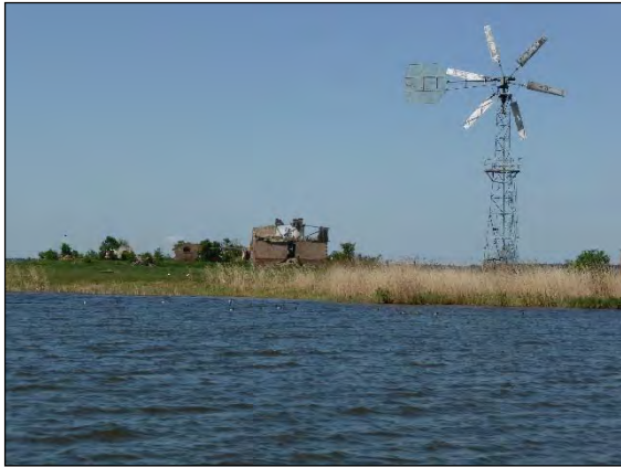
Abb. 1: Blick von Süden auf die Insel Riether Werder mit der Ruine des Wohnhauses und dem nicht mehr betriebenen Schöpfwerk. Ende der 1950er Jahre wurde das Gebäude als Wohnhaus aufgegeben und 1989 der Betrieb des Schöpfwerkes eingestellt (STEGEMANN et al. 2005). (Foto A. Kleeberg, April 2014)
