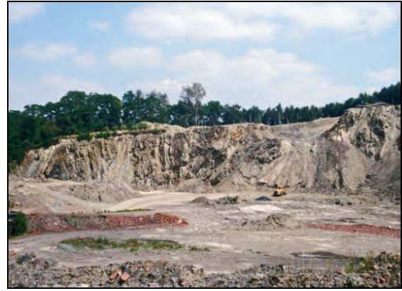
Abb. 27: Nach Stilllegung des Ziegeleibetriebes 1989 folgte der Abriss der Brecheranlagen und Beginn der Umgestaltung und Vergrößerung der Grube zur Aufnahme von Bauschutt mit Verschüttung der fossilführenden Schichten. Foto: L. Koch.
