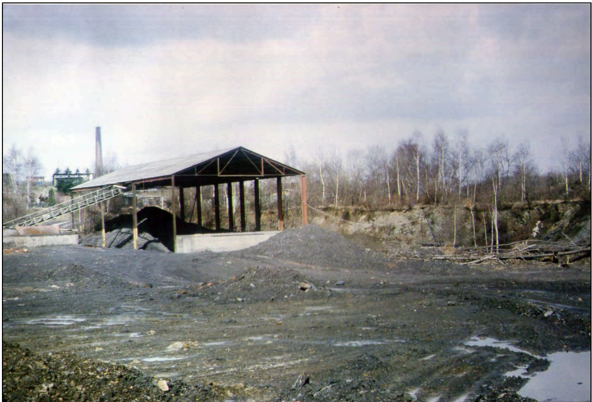
Abb. 20: Lagerhalle auf dem Gelände der Ziegeleigrube Vorhalle am 30.3.1986. Foto: W. Sippel.
