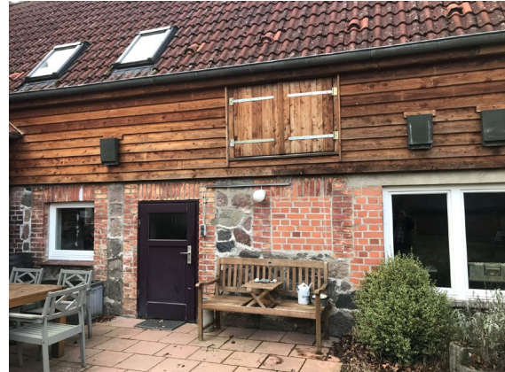
Abb. 1: Ostexponierte Feldstein-/Ziegelwand mit darüberliegender Holzverschalung.
