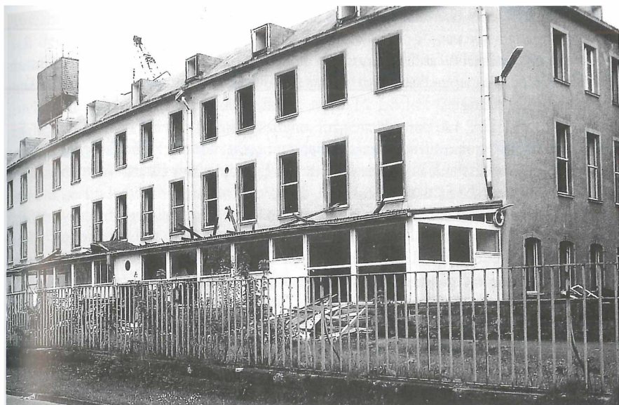
Zum Abriss bestimmtes Gebäude der ehemaligen Arolser Kaserne
