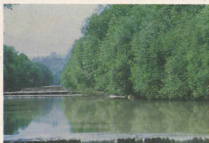
Verbauter Flußlauf. Hier entstehen keine Kiesbänke mehr
