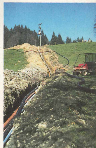
Wasser- und Stromversorgung müssen mit großem Aufwand über weite Strecken den Berg hinauf verlegt werden
