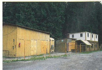
Die Baracken der kanadischen Firma am Probestollen
