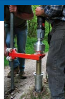
LBV-Aktive beim Einbohren eines Schraubfundamentes im Rainer Wald
