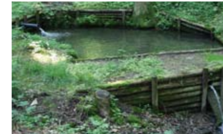
Zerstört: Verbauung als Fischbecken
