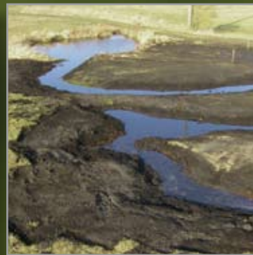
Mäandergraben statt Rohrleitung: Maßnahme im Sallacher Moos
