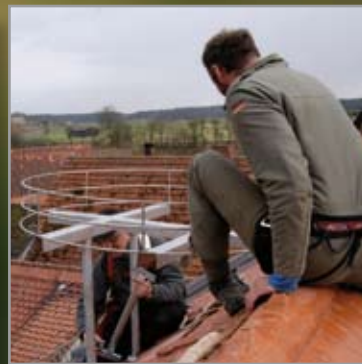
Bau einer Horstplattform: Mönchsambach/Ofr.
