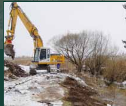
Mit dem Bagger wird der Lebensraum für die Keiljungfer optimiert
