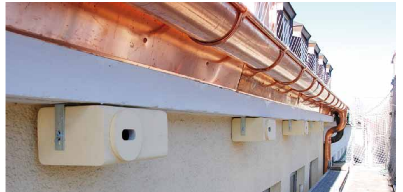
Eine Reihe Mauerseglerquartiere wurde hier außenliegend direkt unter der Traufe angebracht
