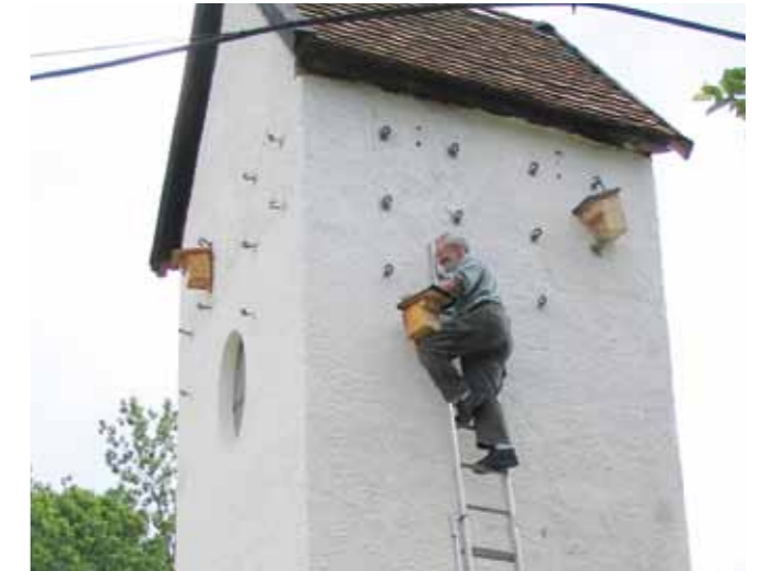
Kreative Mitglieder der LBV-Kreisgruppe Bad Tölz/Wolfratshausen bauten ein ehemaliges Trafo-Haus in Mooseurach in ein Höhlenparadies für Dohlen, Mauersegler und Fledermäuse um
