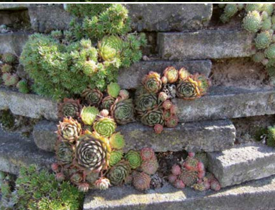
▲ Recycling-Mauer aus Betonplatten mit Hauswurz bepflanzt.
