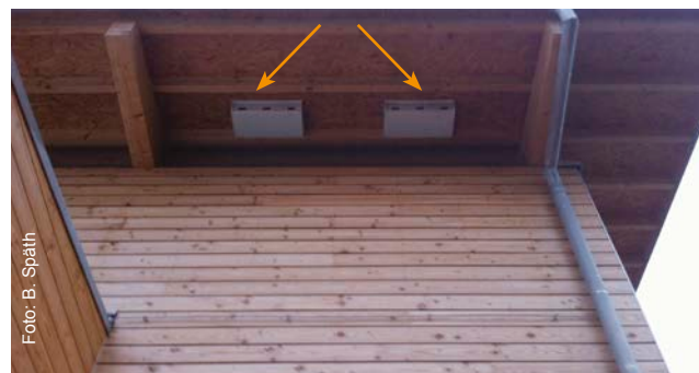
Die Mauerseglerkästen (Pfeil) fallen an der Fassade kaum auf.
