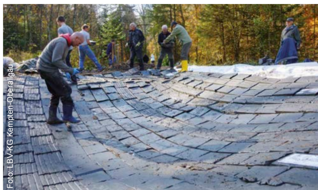
Aus Tonplatten wird die Teichmulde geformt und anschließend mit einem hydraulischen Stampfer verdichtet.
