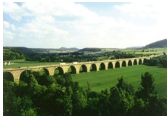
Abb.1: Nordseite der Autobahnbrücke Jena-Göschwitz.
