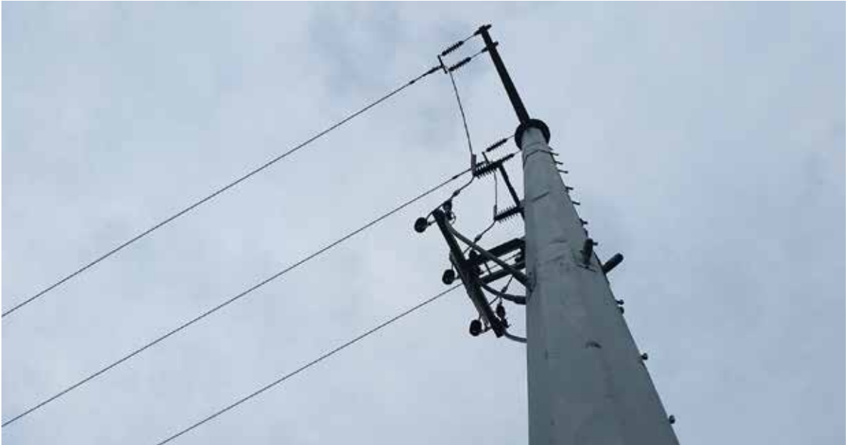
Abb. 1: Abspannmast in Piding/Südbayern; auf diesem Masten sind vier Waldraupe zeitgleich durch Stromschlag umgekommen. Foto: J. Fritz
